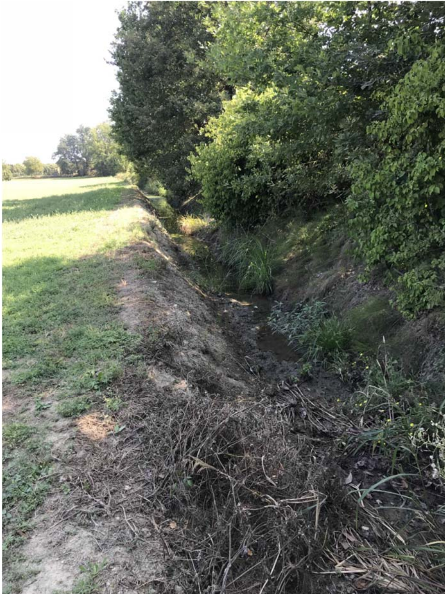
Fig. 5.2 Fotografia canale di scolo esistente.
